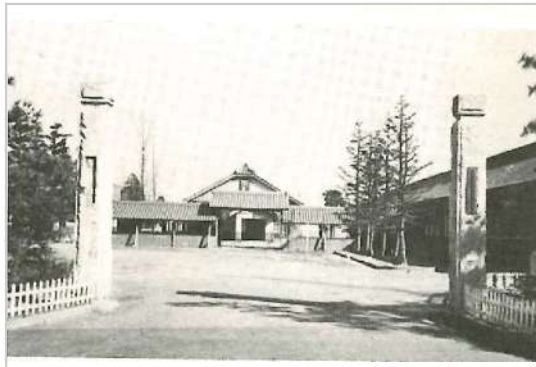
倒壊前の正面の渡り廊下
