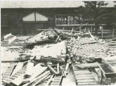
倒壊した正面渡り廊下と瓦
